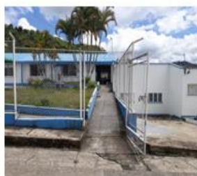
Acceso desde la calle al área administrativa
